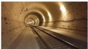
Couverture en tunnel à Saverne (67)
