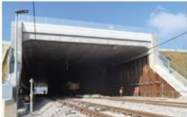
Tranchée couverte à La Milesse (72)
